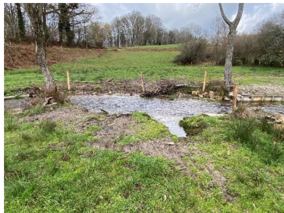
Après travaux : clôture et réalisation d'un passage à gué sur la droite
