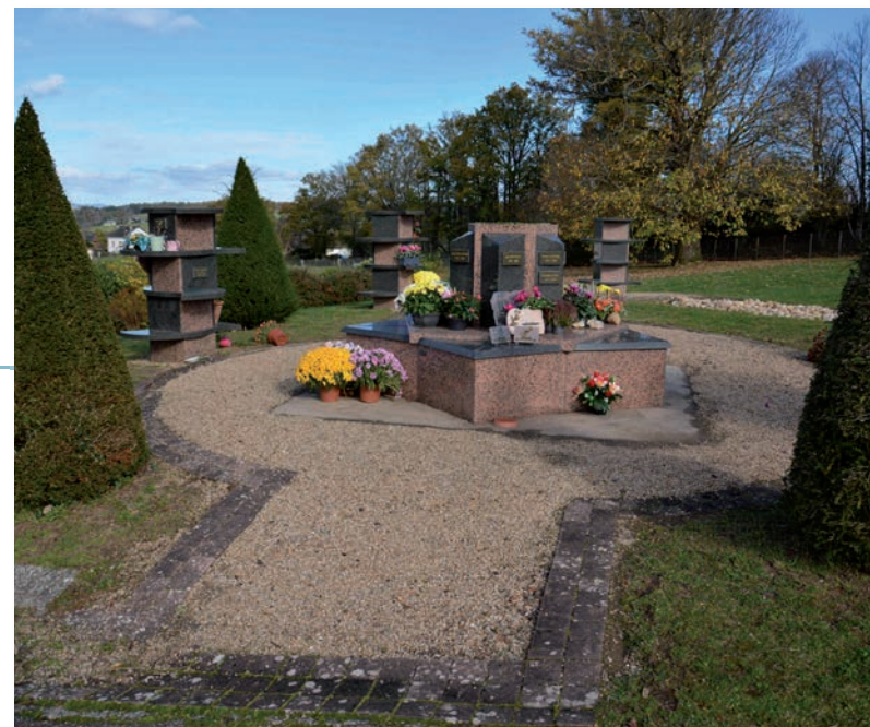
Châteauneuf-la-Forêt : le déchaussement des pavés et le manque de graviers sont aujourd'hui problématiques, retrouver une surface entièrement engazonnée est à privilégier
