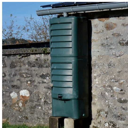
Saint-Gilles-les-Forêts : récupérateur d'eaux pluviales
