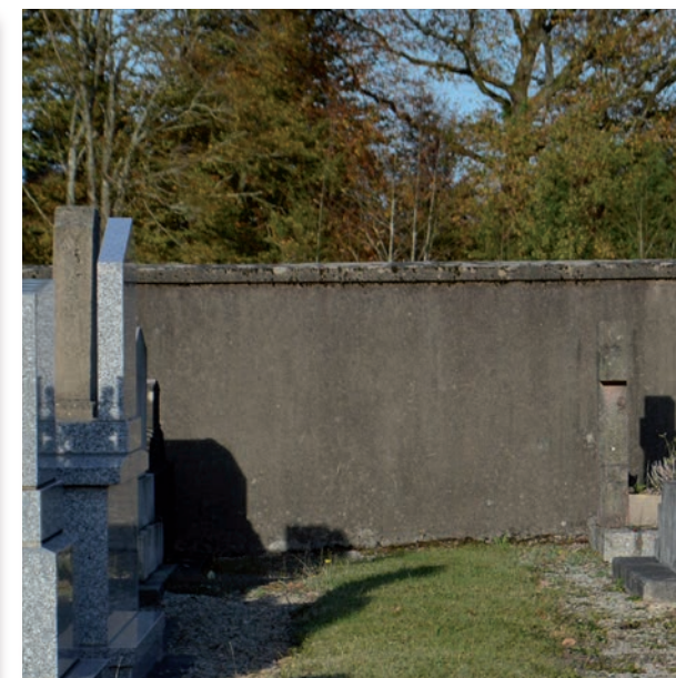
Le Châtenet-en-Dognon : mur crépi
