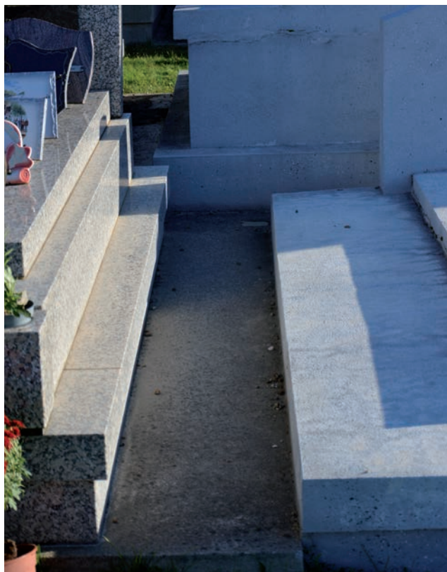
Sussac : semelle en béton
