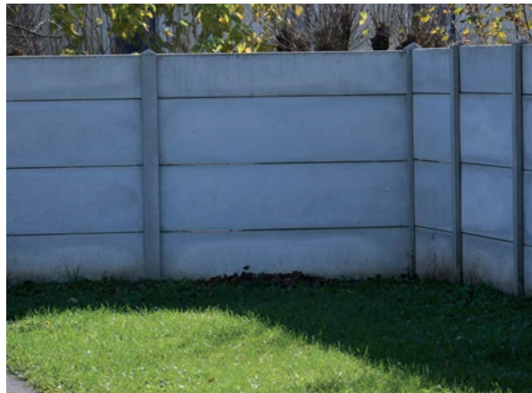
Sussac : palissade en béton dans l'agrandissement du cimetière
