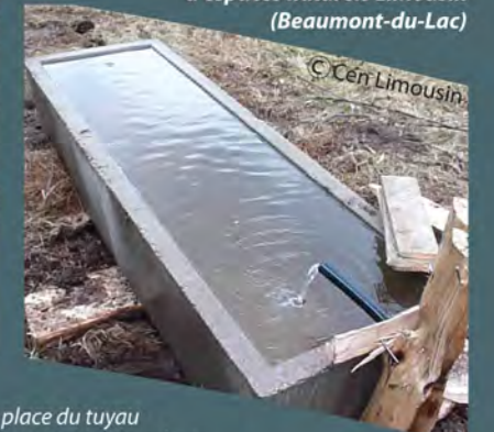
-4- Le bac en bout de réseau installé
