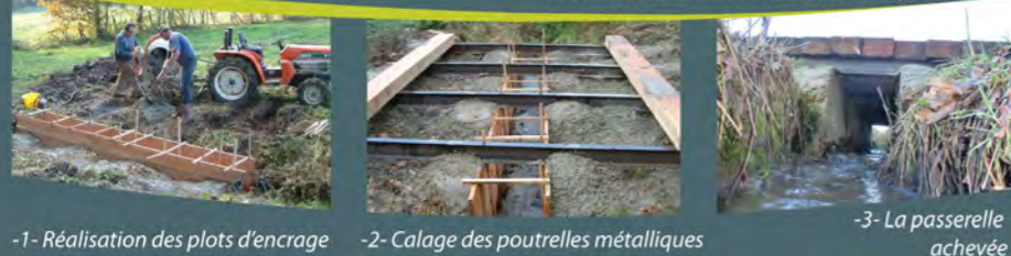
Réalisation d'une passerelle en poutrelles métalliques et madriers M. Philippe Poutissou (Champnétery)
