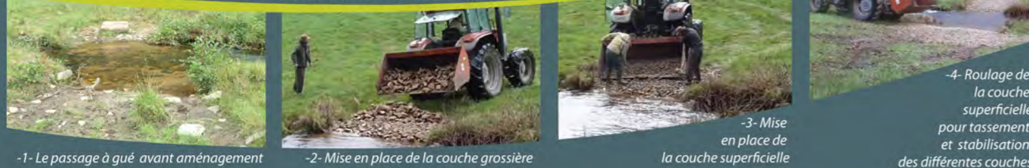
Réalisation d'un passage à gué avec empierrement simple des berges M. Roland Lerousseau (Domps)
