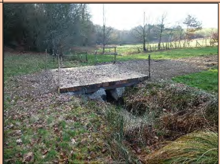
Passerelle achevée avec tablier bois
