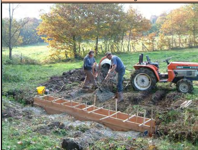
Béton coulé sur les berges
